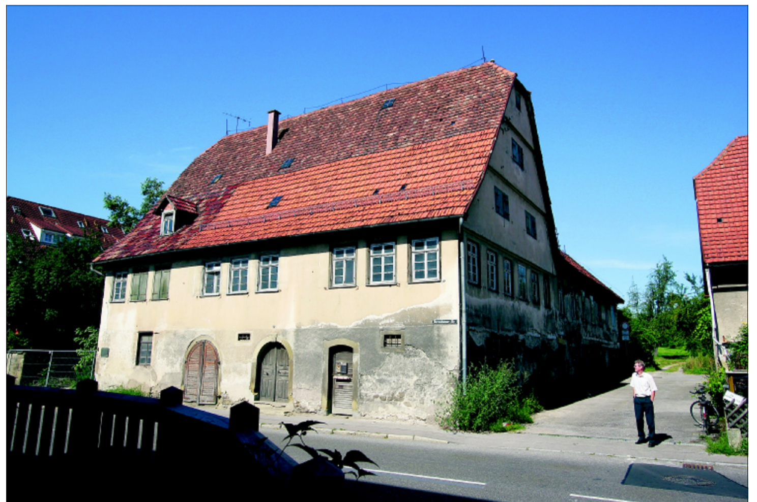
Ihren alten Digelhof wollen die Maichinger in einer Art Bauherrngemeinschaft von Grund auf sanieren
